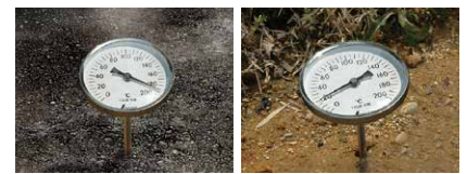
アスファルトの温度測定に
