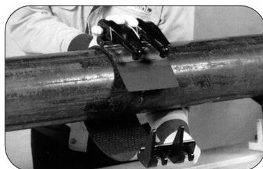
②KCタイプのボルトをブラケットから外し、損傷箇所がクランプの中心に来るように被せます。
