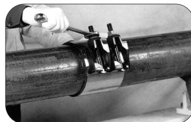
③中央のナットから交互に均一に締め付けてください。ナットを締め付けて約30分後、増締めしてください。
